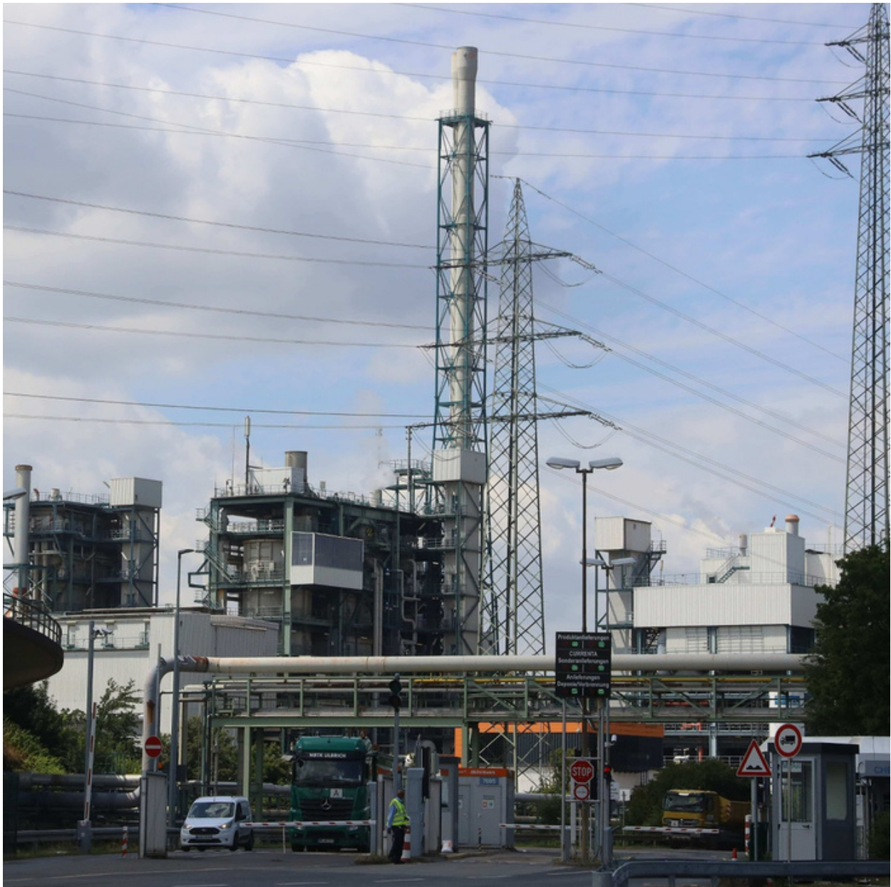
Die Müllverbrennungsanlage des Chemparks in Bürrig. FOTO: UM
