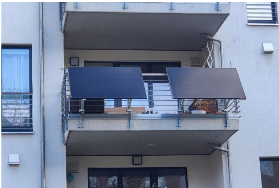
Die beiden Panels des Balkonkraftwerks Anker Solix RS40P wurden zunächst mit einem Winkel von 35 Grad aufgebaut. (Foto: Friedhelm Greis/Golem.de)
