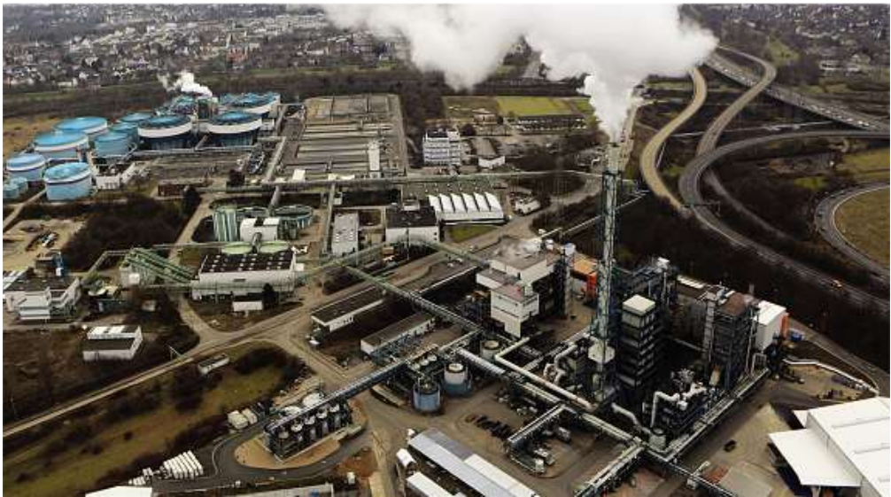
Vor der Explosion sah es im Currenta-Entsorgungszentrum Bürrig so aus. Das Tanklager ist etwas unterhalb der Mitte des Bildes zu sehen.
